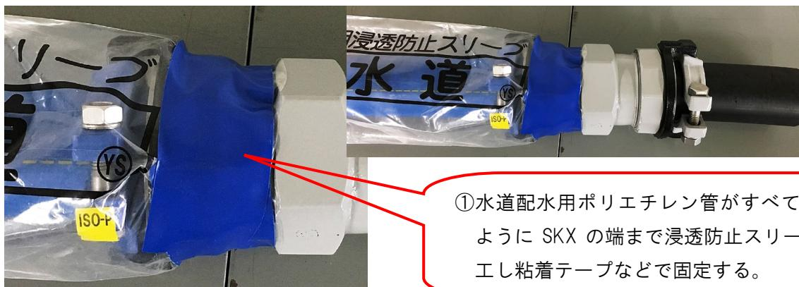
②SKX に付属されるポリスリーブを水道配水用ポリエチレン管まで施工し粘着テープなどで固定する。
